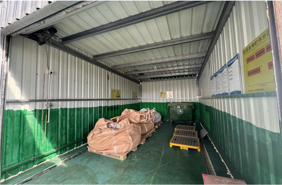
图 3-8 危废仓库内部
